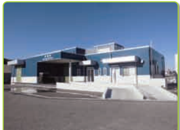
図2 磯崎漁協新荷捌所
